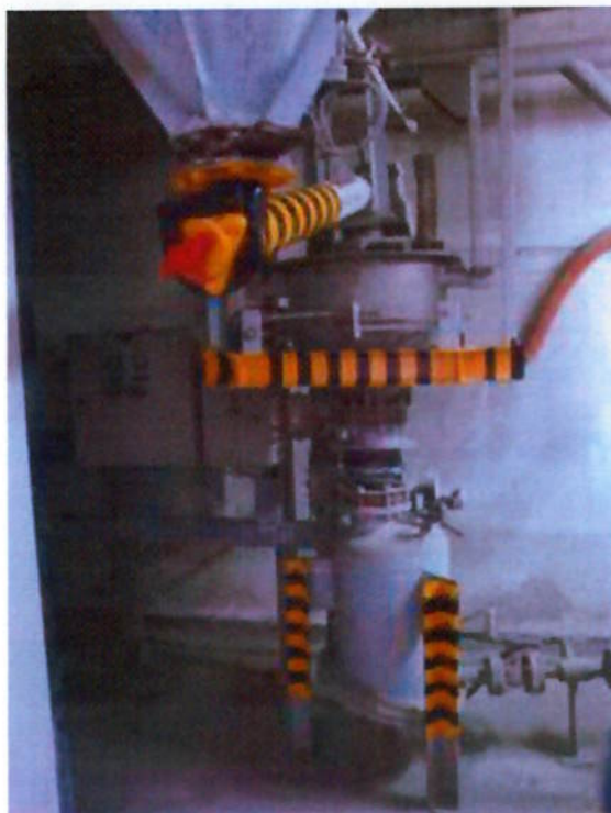
Figura 14 – Depois do Kaizen com sinalização das quinas
